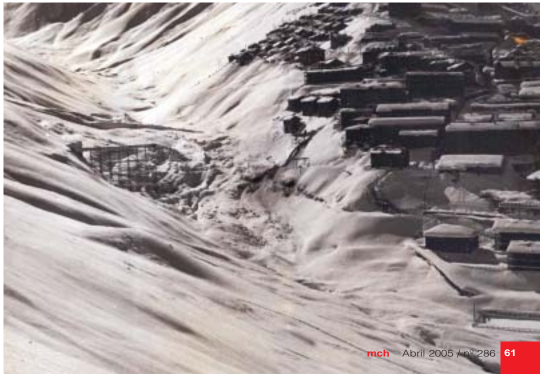
El puente Rebolledo destruido por un rodado.
