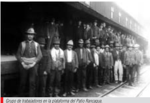
Grupo de trabajadores en la plataforma del Patio Rancagua.
