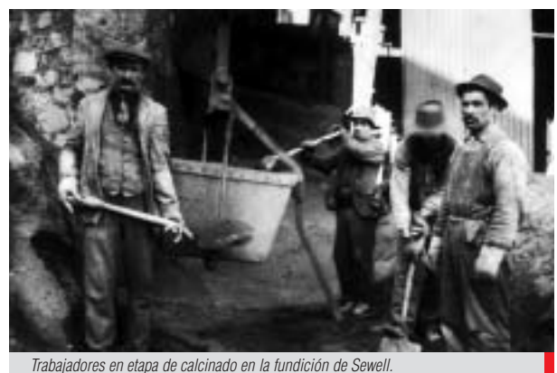
Trabajadores en etapa de calcinado en la fundición de Sewell.
