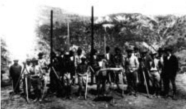
Topógrafos en las labores de preparación de terreno de Caletones.
