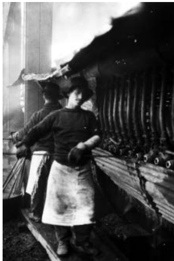
El oficio de punzador en la Fundición Sewell, 1914.
