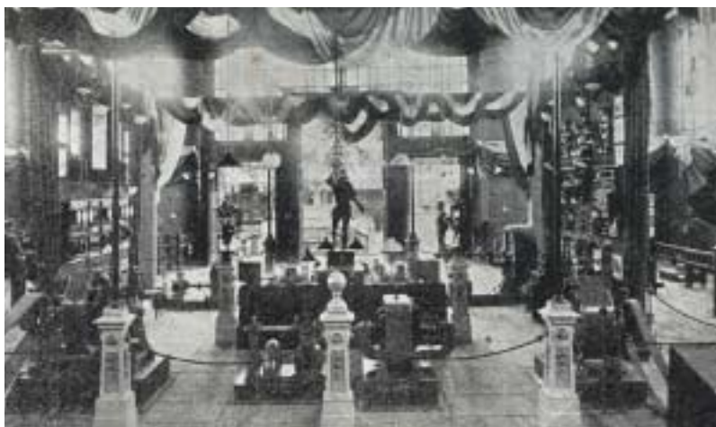
Interior de la Sección de Electricidad de la Exposición de Minería y Metalurgia de 1894.
